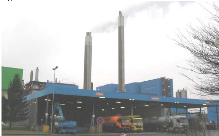
Figura 2. Vedere zona de descarcare a deseurilor la incinerator
